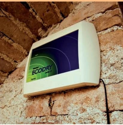
System bricht die Kapillarkräfte des Wassers und hindert es am Aufsteigen im Mauerwerk. Sobald die Trocknung vollständig abgeschlossen ist, werden die betroffenen Stellen neu verputzt und gestrichen. Die
